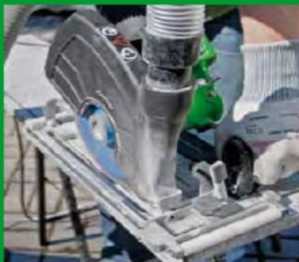
Natursteinfensterbank – Tropffuge hier: Trockenschnitt mit Eintauchtiefenbegrenzung
