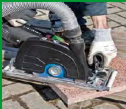
Betonwerkstein – Terrassenplatten hier: Trockenschnitt
