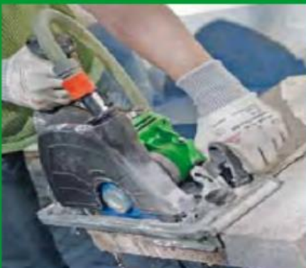
Naturstein-Setzstufe kürzen hier: Nassschnitt mit Winkelanschlag
