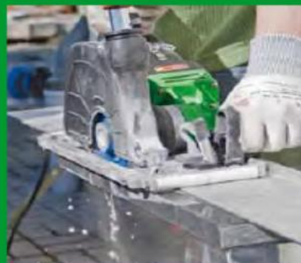
Naturstein-Küchenarbeitsplatte ablängen hier: Nassschnitt mit Führungsschiene
