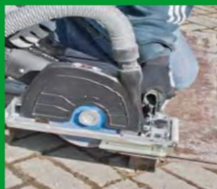
Betonborde im Galabau hier: Trockenschnitt
