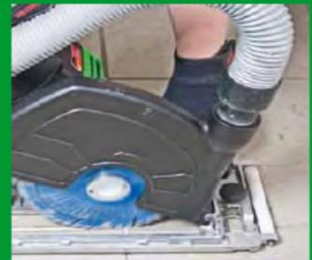
Fugensanierung hier: Trockenschnitt mit Eintauchtiefenbegrenzung
